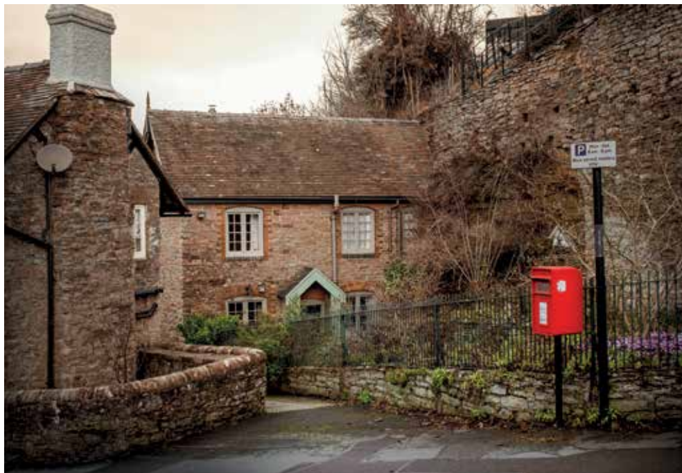
Typische englische Bauweise
